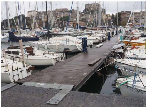
Ogni modulo poggia su 3 galleggianti in calcestruzzo riempiti di schiuma poliuretana delle dimensioni di 1,4x2,0x0,7 metri, tranne il primo modulo collegato alla banchina in muratura che è dotato di un solo galleggiante di dimensioni maggiorate 2,4x2,0x0,7 metri posto sul lato opposto alla banchina stessa.
