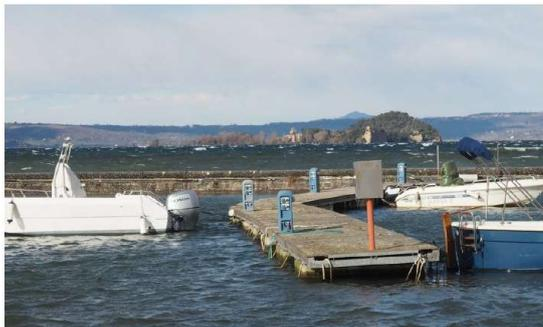
Al centro del pontile è presente un elemento angolato in acciaio zincato che permette di spezzare la linearità del pontile galleggiante.
